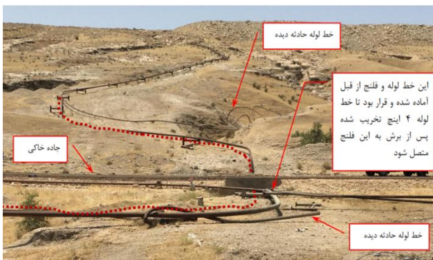
نمایی از محل انجام کار و خط لوله ۴ اینچ تخریب
